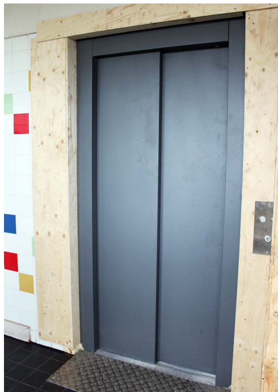
De schachttoegang (nog niet afgewerkt)
