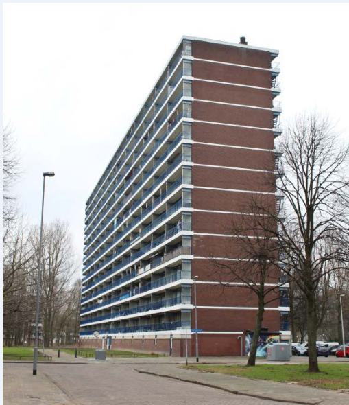
De vervanging van een viertal liften in twee woongebouwen van Woonstad Rotterdam staat centraal in dit artikel.
